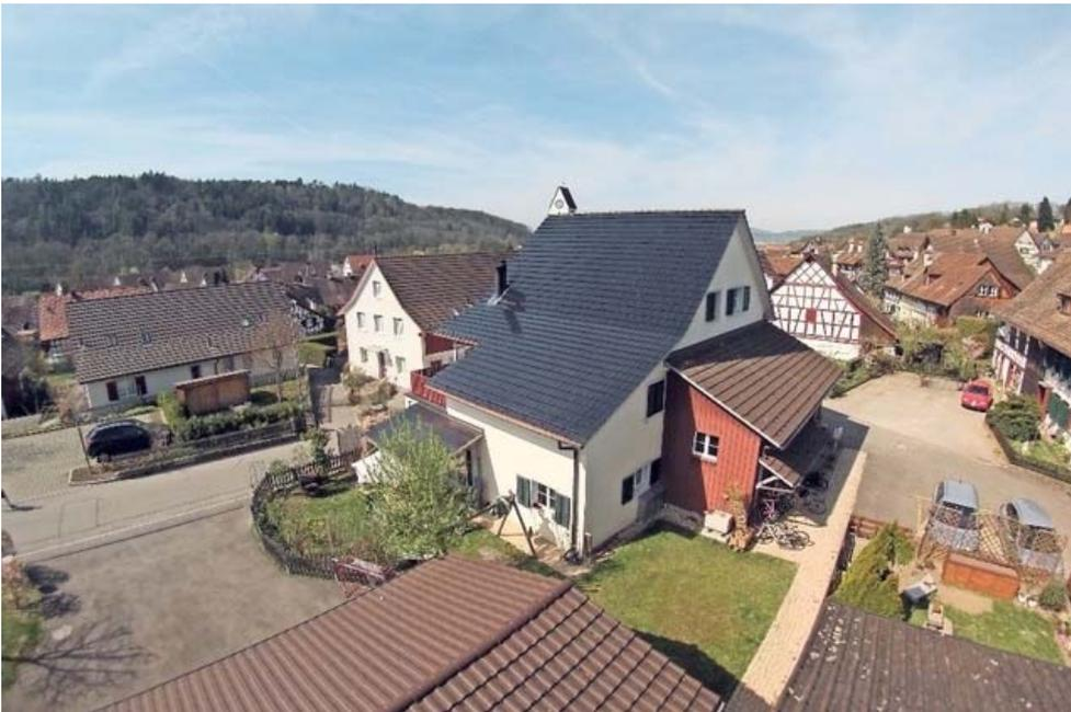
Das Haus an der Friedhofstrasse in Glattfelden dient als Referenzanlage. Statt grossflächiger Photovoltaikmodule erzeugen Solarziegel den Strom, die auf dem Dach leichter zu verbauen sind. Bild: zvg
